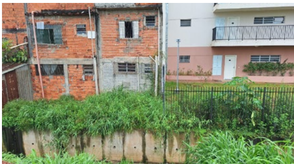
Figura 21: Residências e córrego situados no limite do parque
