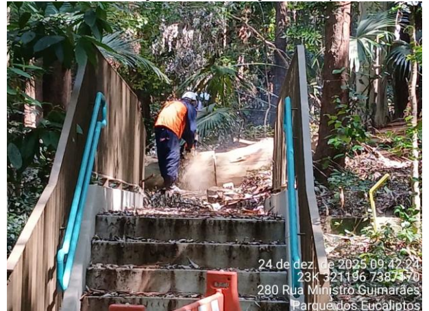
Figura 35: Seccionamento de eucaliptos caídos para remoção e destinação adequada
