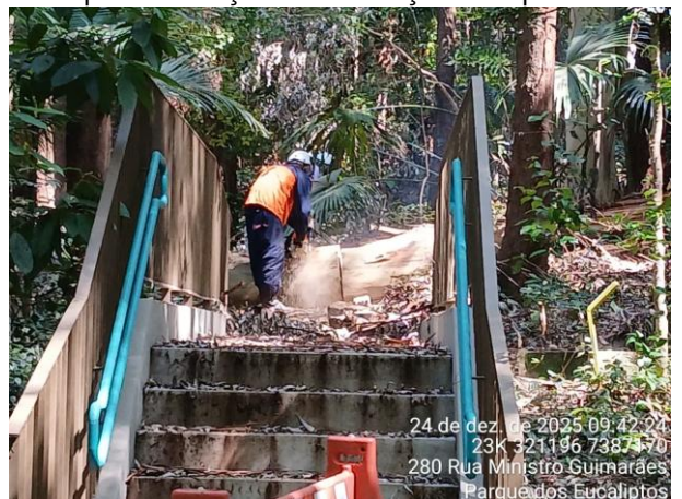
Figura 40: Seccionamento de eucaliptos caídos para remoção e destinação adequada
