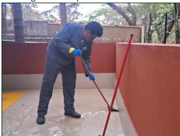
Figura 79: Limpeza da área multiuso
