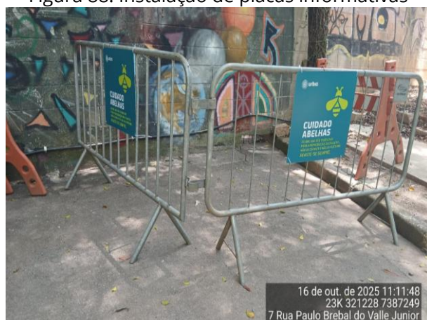
Figura 88: Instalação de placas informativas
