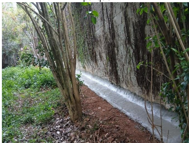
Figura 87: Instalação de manta no muro do parque
