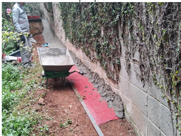
Figura 86: Instalação de manta no muro do parque
