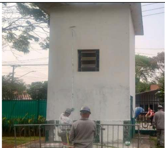
Figura 181: Manutenção de pintura
