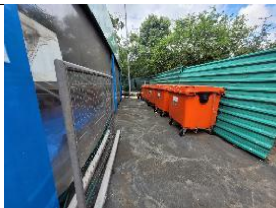
Figura 130: Contentores para armazenamento de resíduos perigosos
