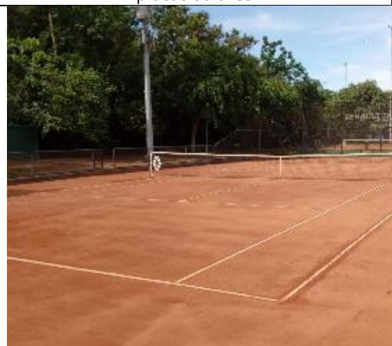
Figura 180: Manutenção preventiva quadra de saibro
