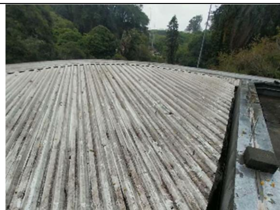
Figura 184: Manutenção Preventiva – Limpeza do telhado Hub Esportivo
