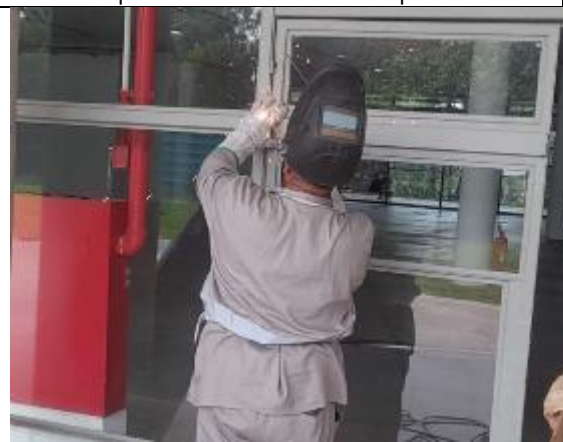
Figura 186: Manutenção de esquadrias
