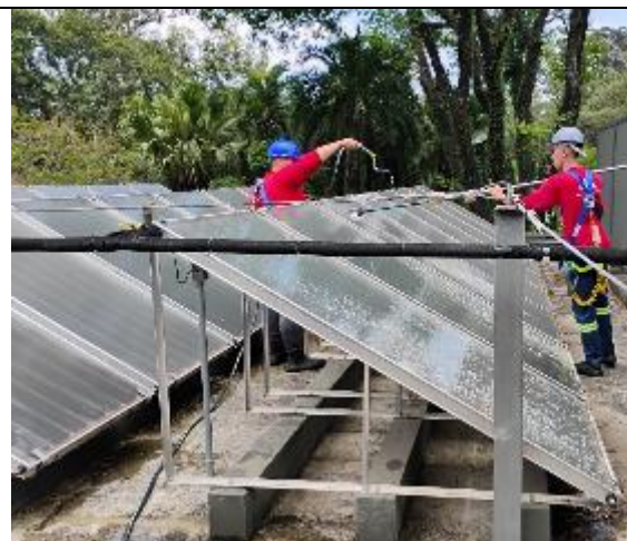
Figura 178: Manutenção preventiva de placas solares
